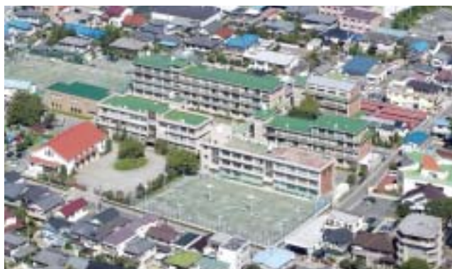
平成24年4月 校舎等耐震事業計画 着手前
