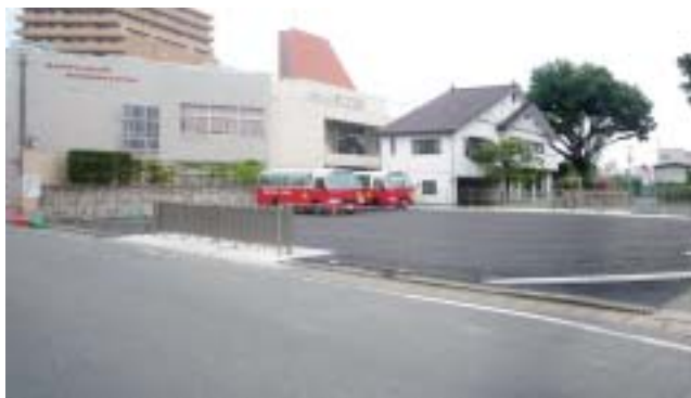
外構（舗装・フェンス）工事完成
